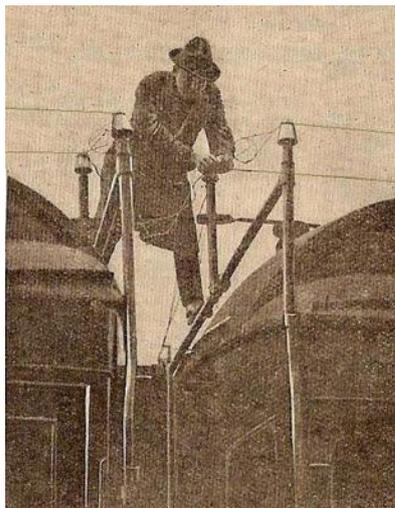
En janvier 1931, à la demande de LAGRUE - F8KW, le R.U. suit les émissions effectuées cette fois à bord d'un train rapide en marche entre Paris et Brest. L'indicatif est "XF8FE", et l'émetteur possède une puissance de 1 kilowatt en télégraphie, sur 75 mètres. Le train doit contacter le poste de Pontoise des P.T.T (indicatif FYD) et la station de Colombes (indicatif F8FF-2). (cf.: *Radio REF - 04/35*).
