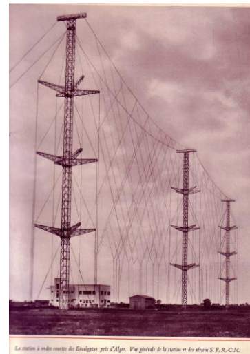
La station à ondes courtes des Eucalyptus, près d'Alger. Vue générale de la station et des mâts S. F. R.-C.M.
