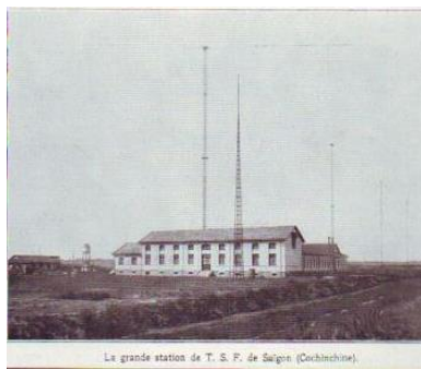
La grande station de T. S. F. de Saïgon (Cochinchine).
